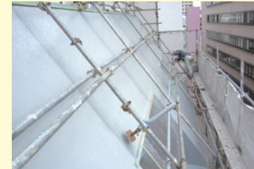
ピンネット工事 + ウレタン塗膜防水をしました
