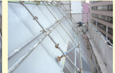
ピンネット工事 + ウレタン塗膜防水をしました
